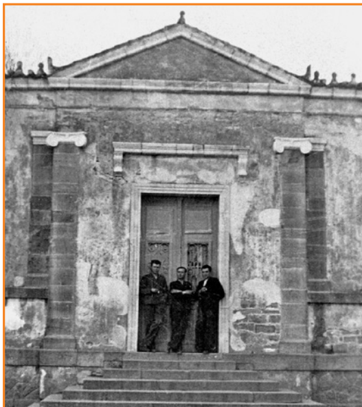
Πρόσοψη του κτηρίου στην αρχική του μορφή
