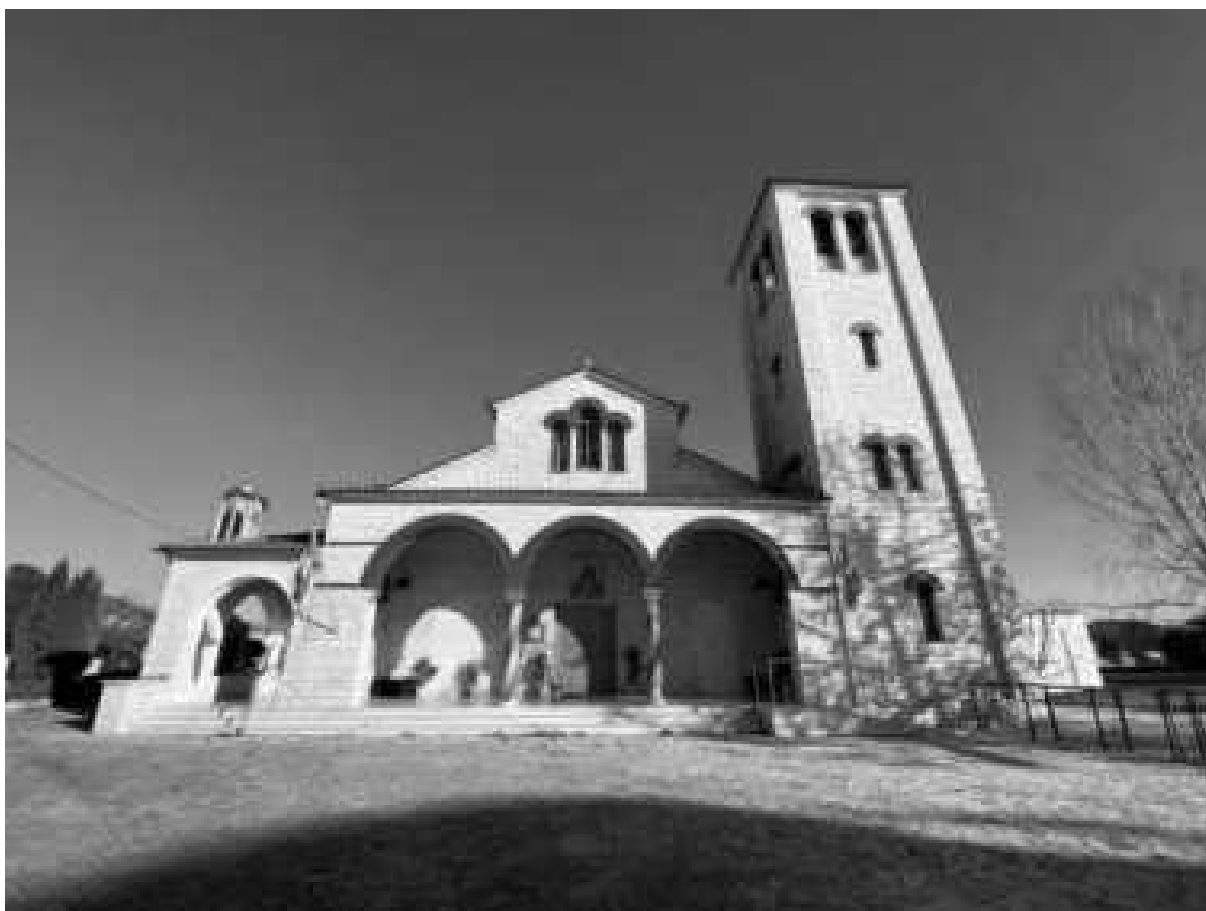
Εικόνα 177: Κύρια είσοδος εκκλησίας, υφιστάμενη ράμπα και κλίμακα στην δυτική πλευρά του Ιερού ναού
