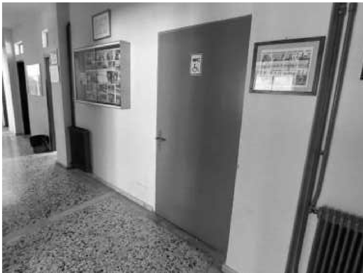
Εικόνα 137: Πόρτα χώρου υγιεινής ΑΜΕΑ καθηγητών
