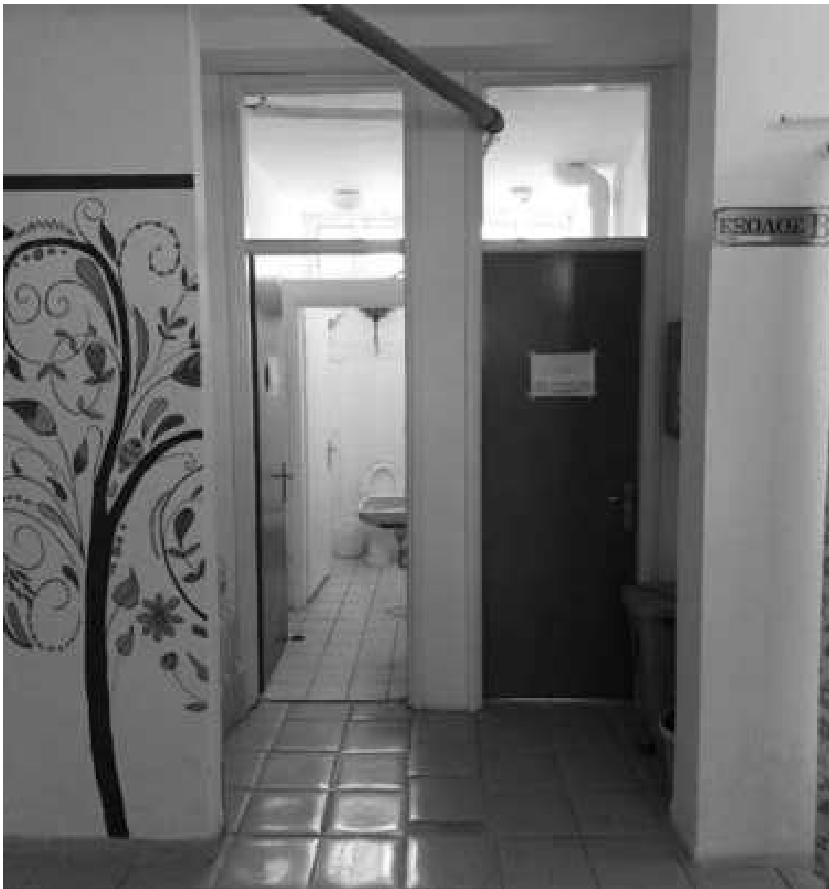
Εικόνα 128: Χώρος υγιεινής καθηγητών ισογείου
