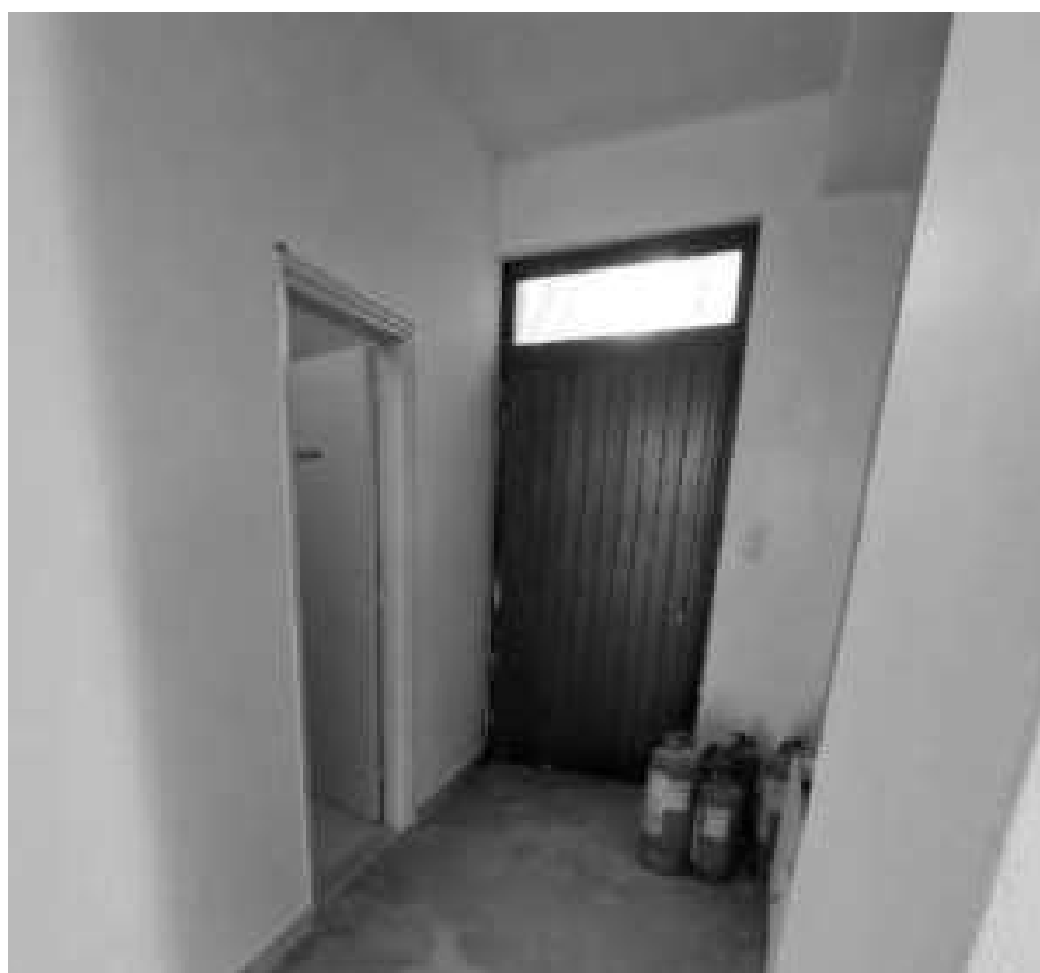
Εικόνα 210: Πόρτα εξόδου κινδύνου από την στάθμη -3,40μ. στο νοτιοανατολικό τμήμα του κτιρίου
