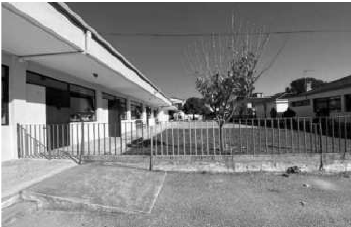
Εικόνα 159: Ράμπα Δημοτικού Σχολείου (Κτίριο 1)
