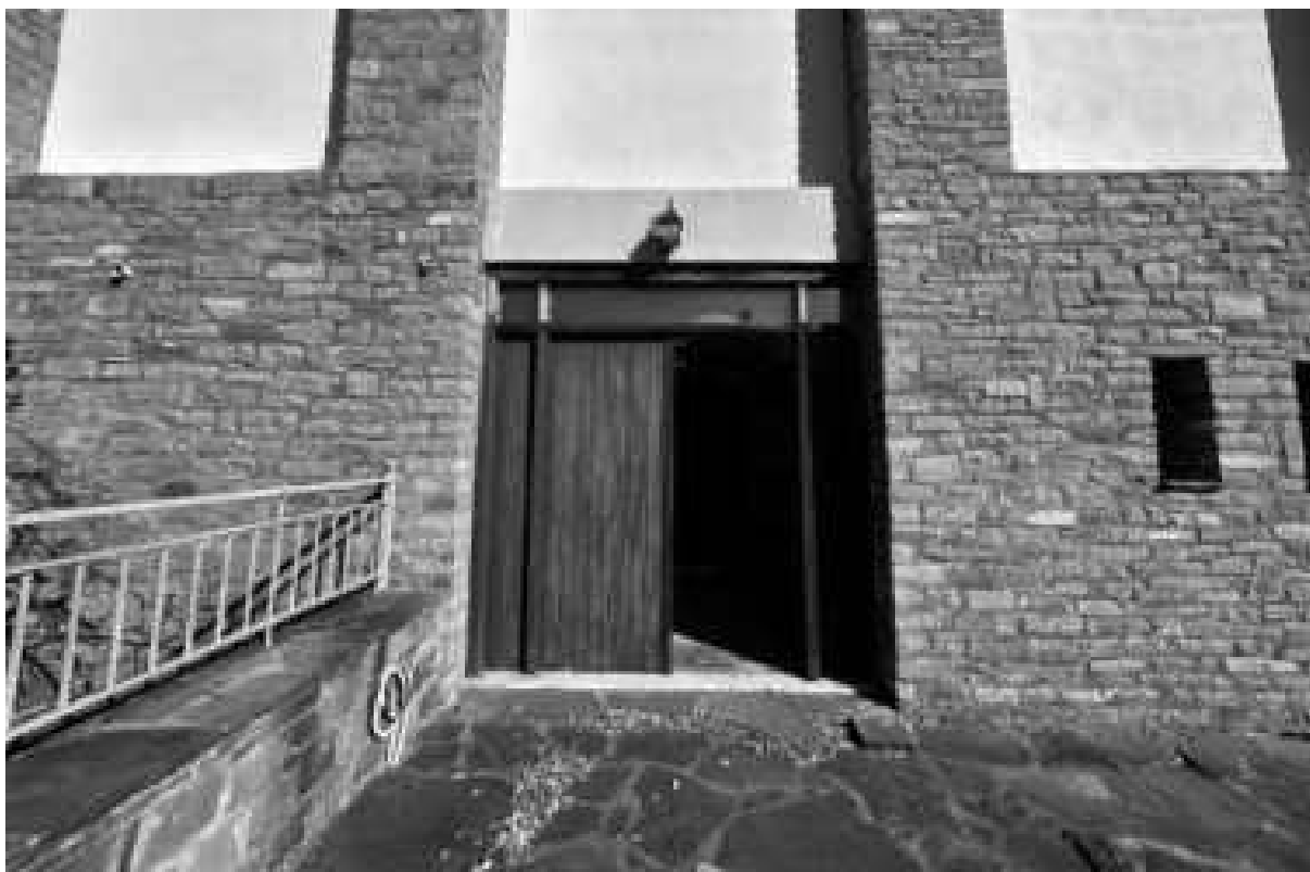
Εικόνα 209: Πόρτα εισόδου από την στάθμη -3,40μ. στην δυτική όψη του κτιρίου
