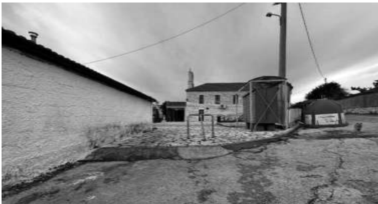
Εικόνα 22: Η ράμπα στην νότια πλευρά του οικοπέδου
