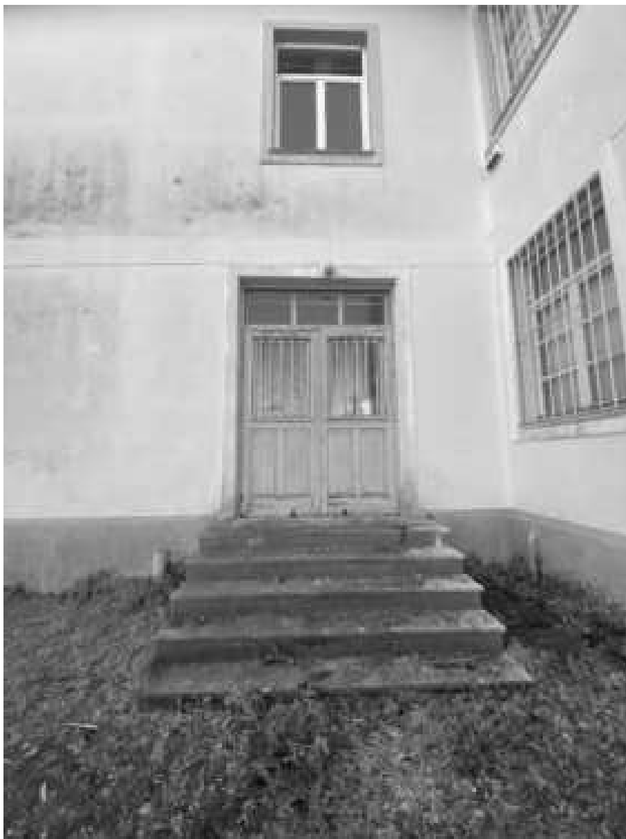
Εικόνα 45: Είσοδος στην δυτική πλευρά του κτιρίου
