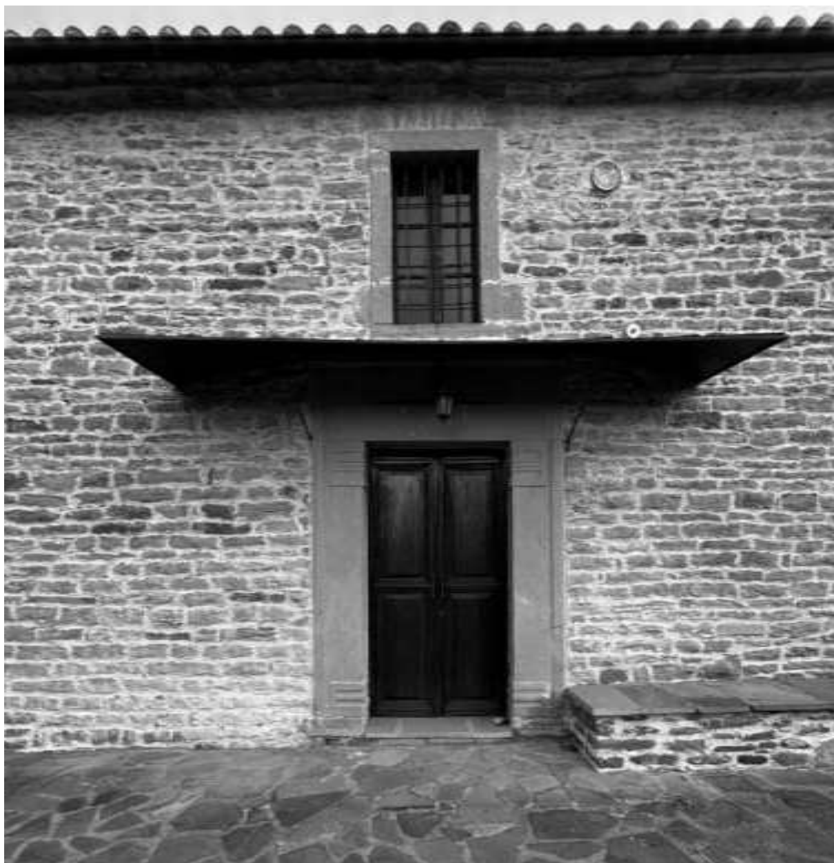
Εικόνα 90: Λεπτομέρεια εισόδου στην νότια πλευρά της εκκλησίας
