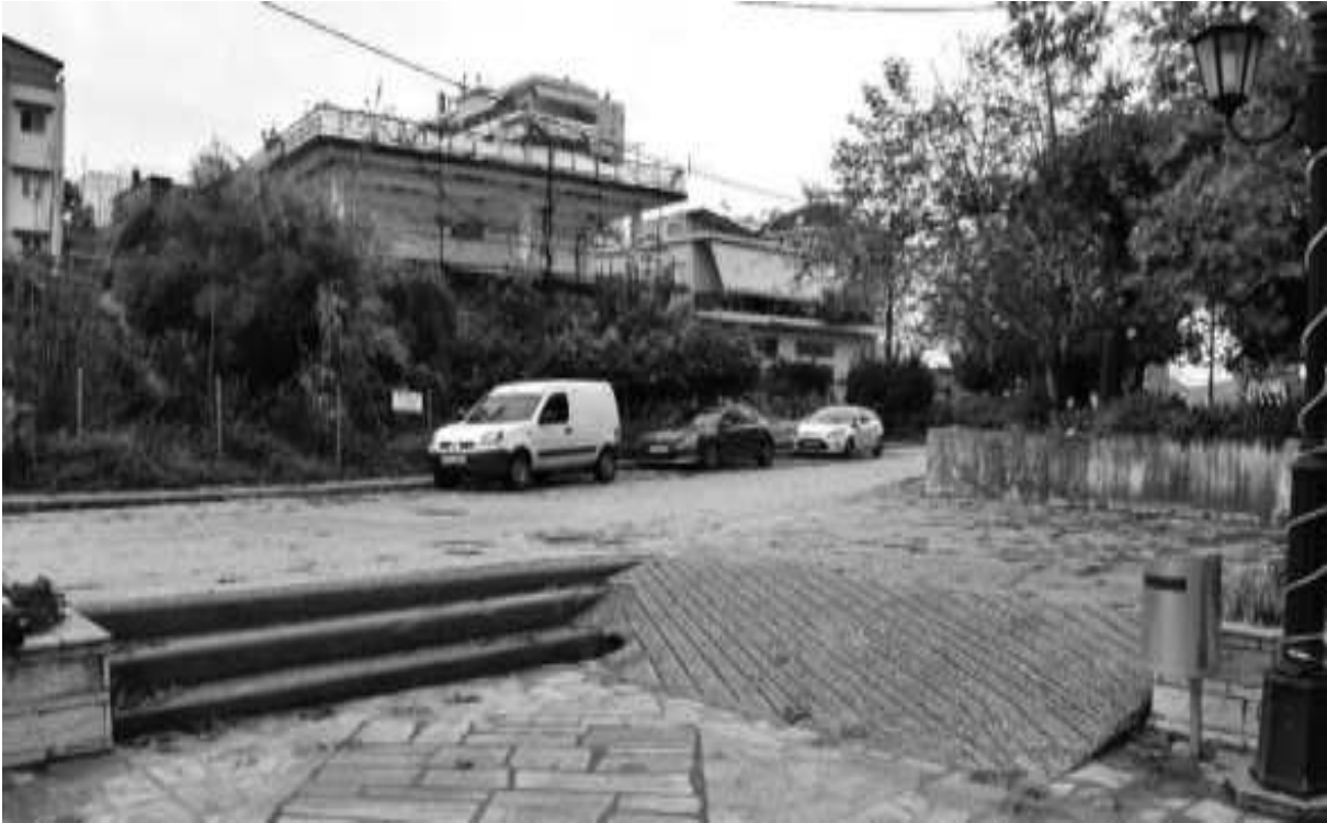
Εικόνα 56: Ράμπα από την στάθμη του πεζοδρομίου
