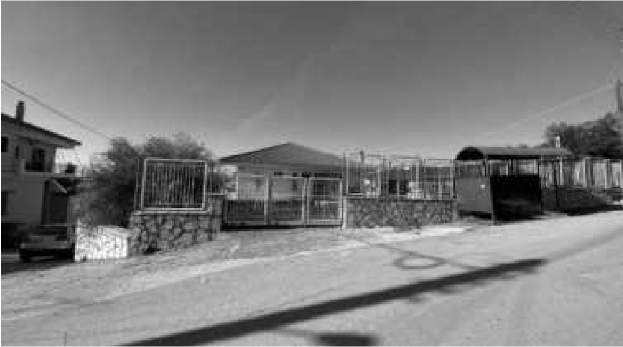
Εικόνα 29: Είσοδος του Νηπιαγωγείου από τον δρόμο
