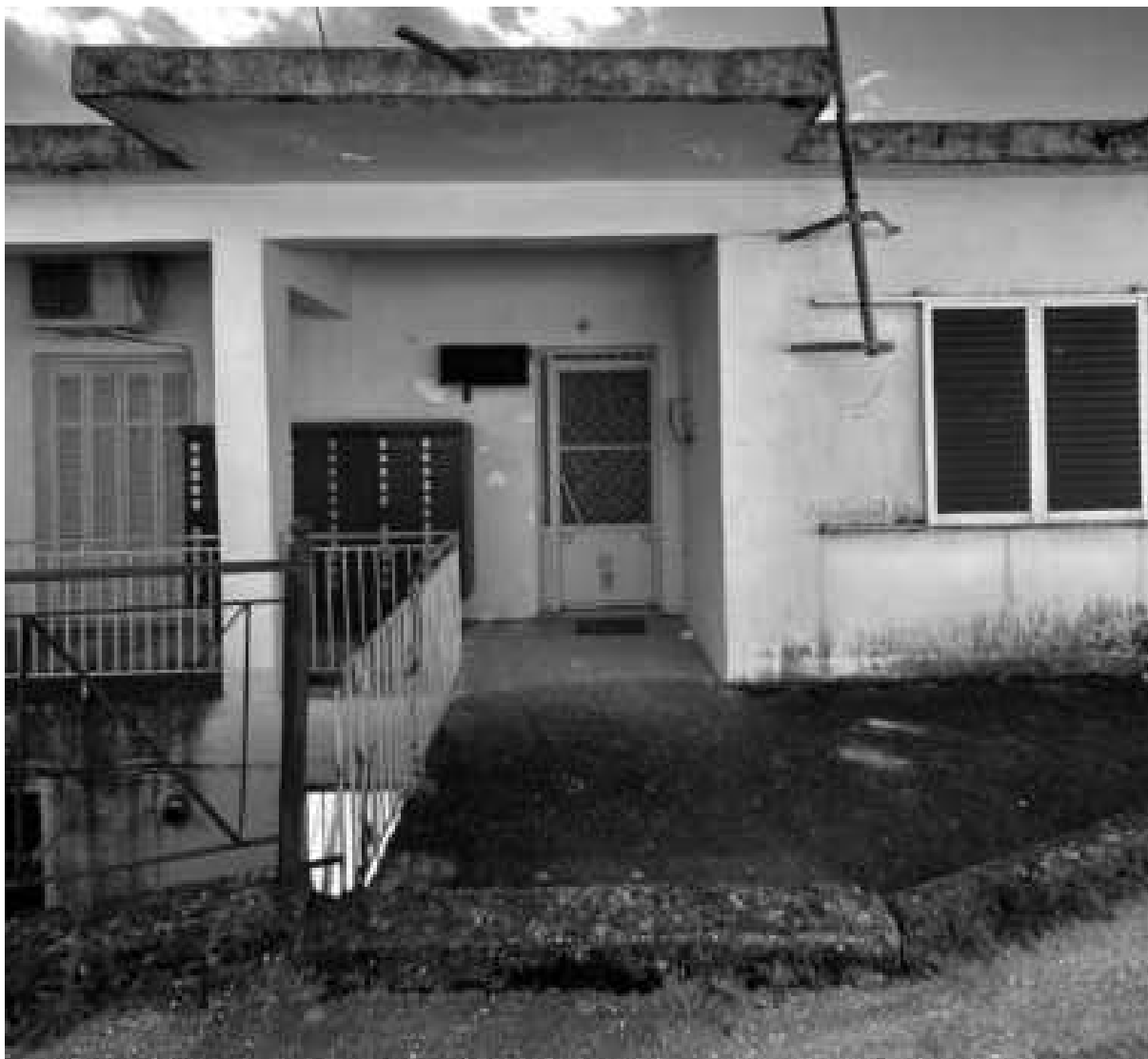
Εικόνα 77: Είσοδος του κτιρίου στην ανατολική του όψη
