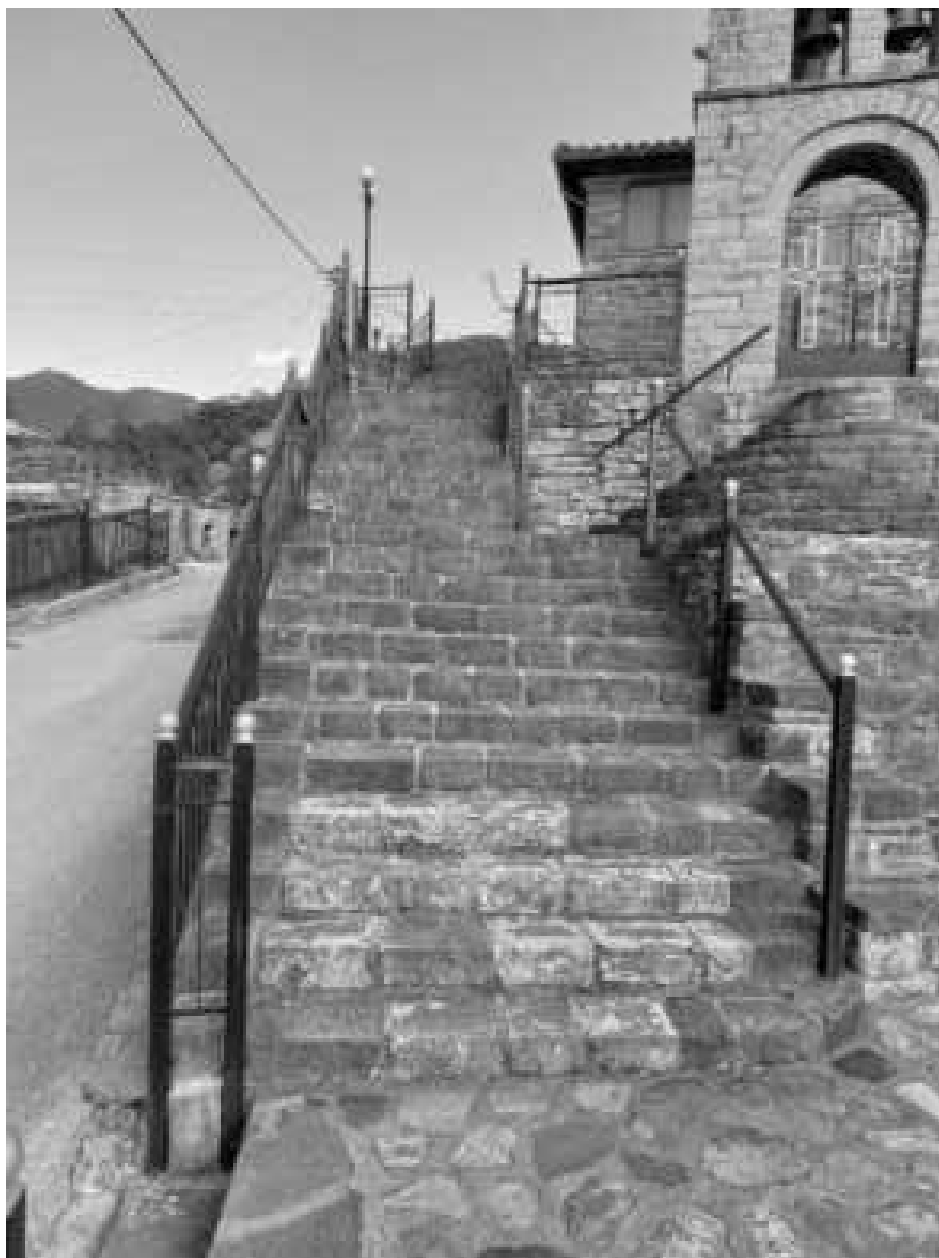
Εικόνα 71: Σκάλα στη δυτική πλευρά του οικοπέδου
