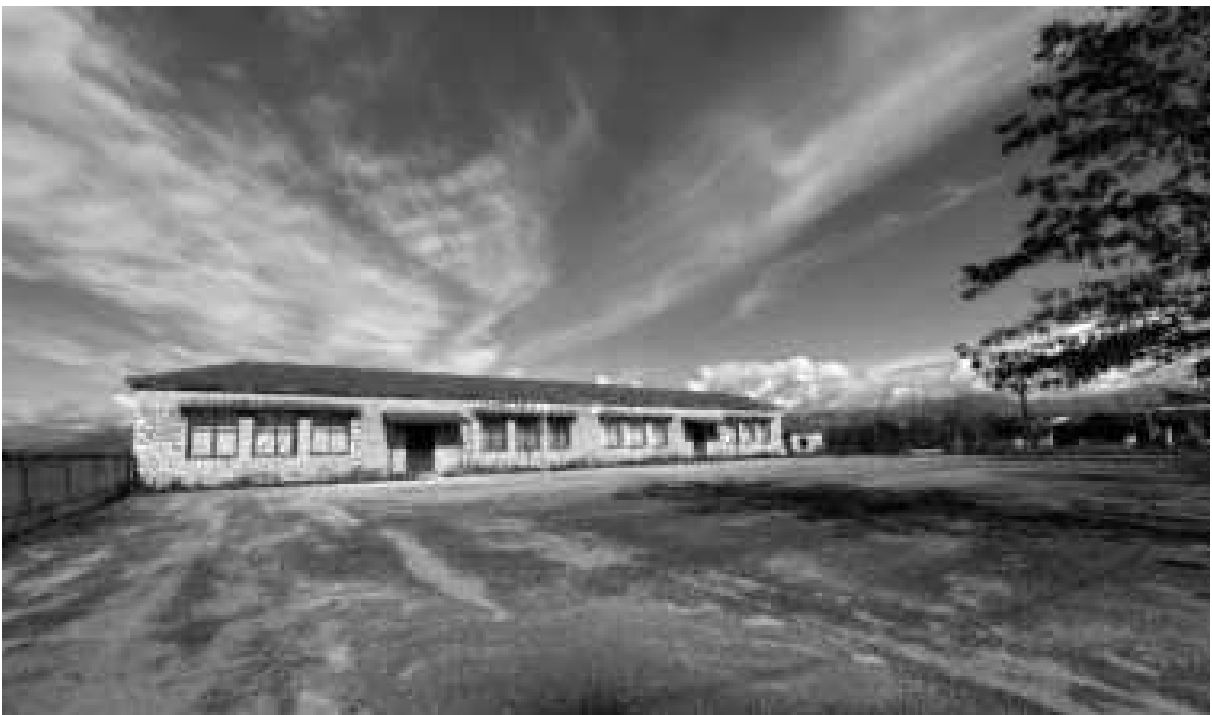
Εικόνα 145: Η νότια όψη του Δημοτικού σχολείου
