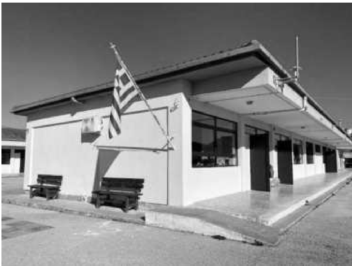
Εικόνα 151: Αίθουσες διδασκαλίας του Δημοτικού σχολείου Νεοχωρίου (Κτίριο 4)
