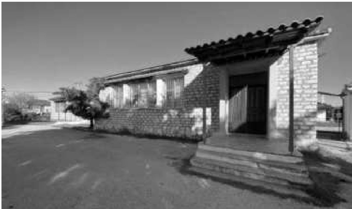
Εικόνα 192: Δημοτικό Σχολείο (Κτίριο 1)
