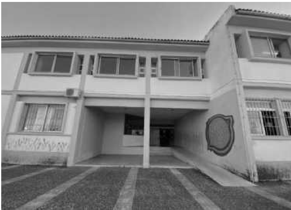
Εικόνα 172: Ράμπα στην δυτική πλευρά του κτιρίου
