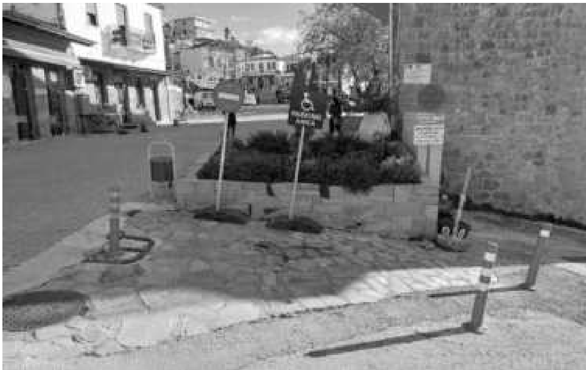
Εικόνα 5: Υφιστάμενη θέση στάθμευσης ΑΜΕΑ σε επαφή με τον χώρο της πλατείας
