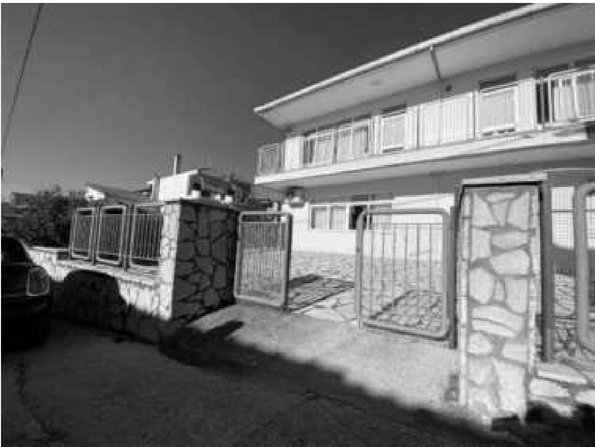
Εικόνα 30: Ράμπα Εισόδου του Παιδικού Σταθμού
