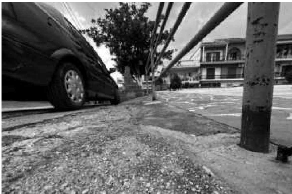
Εικόνα 16: Ράμπα στο νοτιοανατολικό τμήμα της πλατείας
