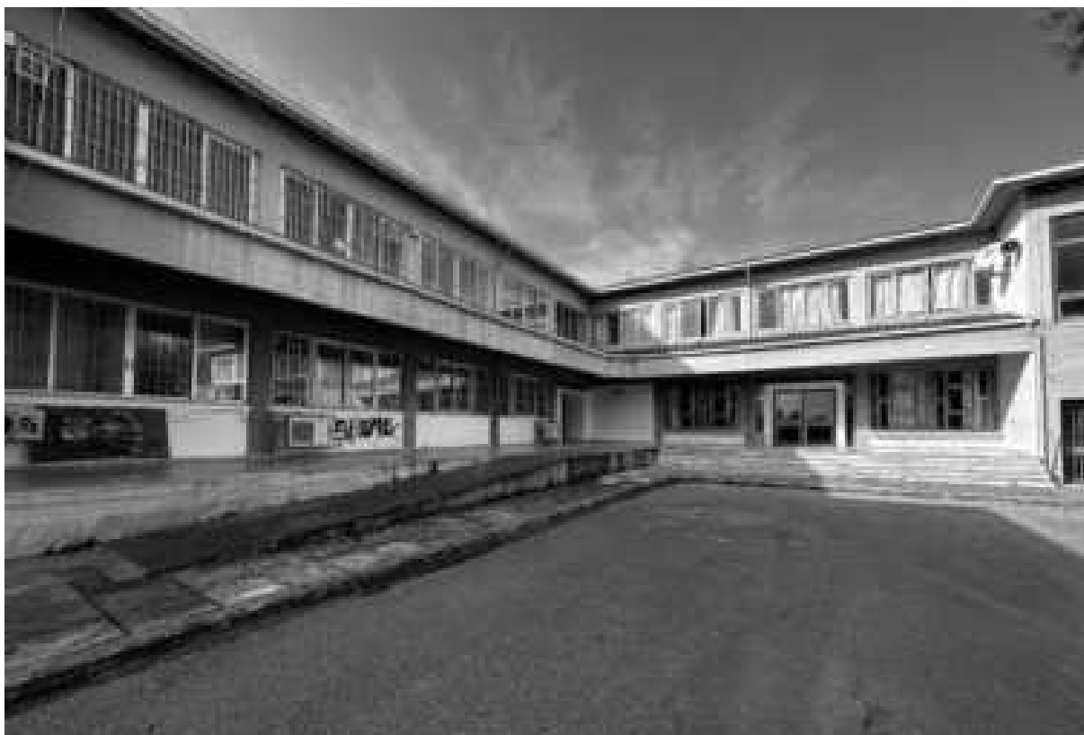
Εικόνα 130: Ράμπα στο κεντρικό τμήμα του κτιρίου
