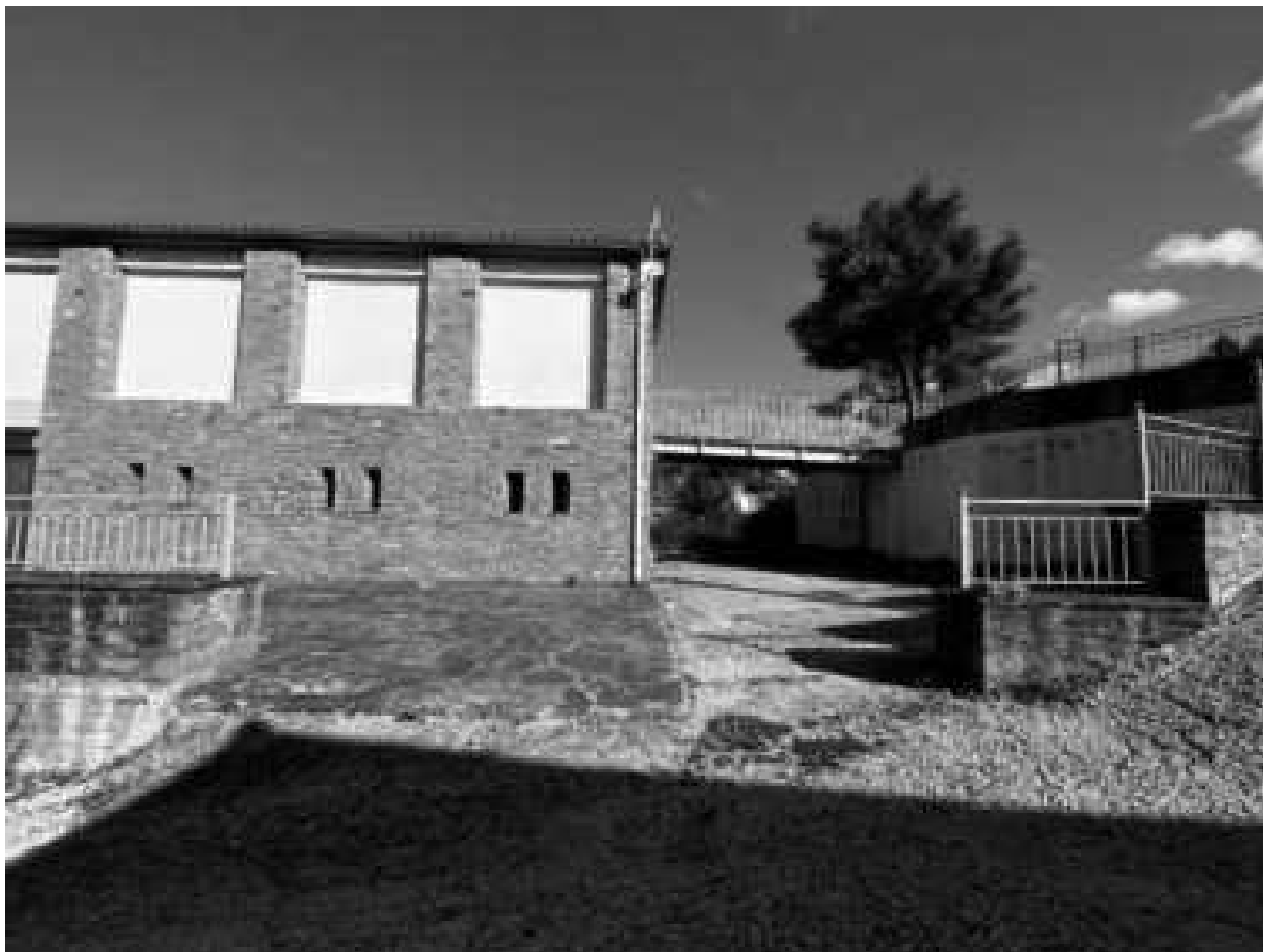
Εικόνα 207: Εξωτερικός χώρος του Λαογραφικού Μουσείου στην στάθμη του ισογείου
