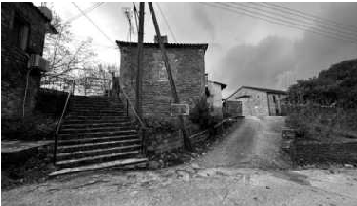
Εικόνα 88: Η υφιστάμενη ράμπα στην βορειοανατολική πλευρά του οικοπέδου
