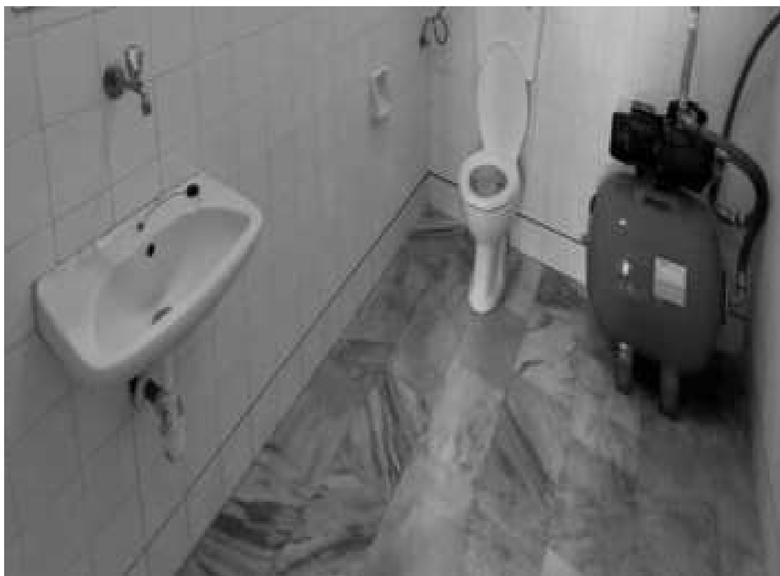
Εικόνα 134: Χώρος υγιεινής ΑΜΕΑ μαθητών
