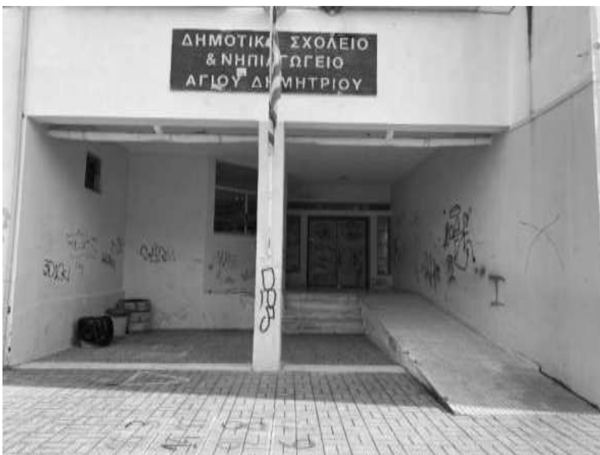
Εικόνα 54: Είσοδος του Νηπιαγωγείου
