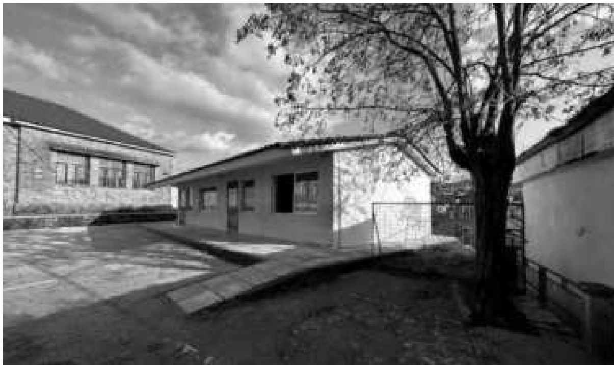
Εικόνα 106: Το Κτίριο 3 των αιθουσών διδασκαλίας
