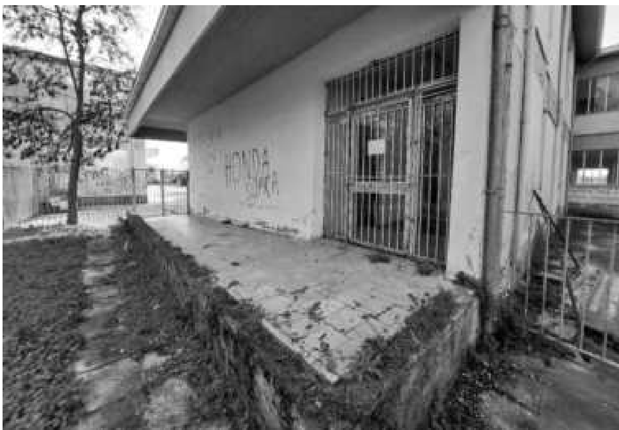
Εικόνα 131: Ράμπα στο βορειοανατολικό τμήμα του κτιρίου
