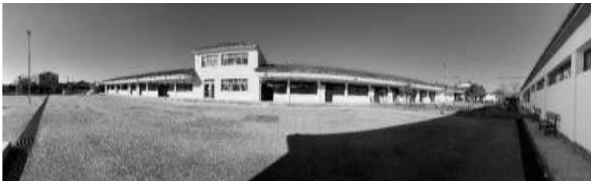
Εικόνα 150: Δημοτικό σχολείο και Νηπιαγωγείο Νεοχωρίου (Κτίρια 1 και 2)
