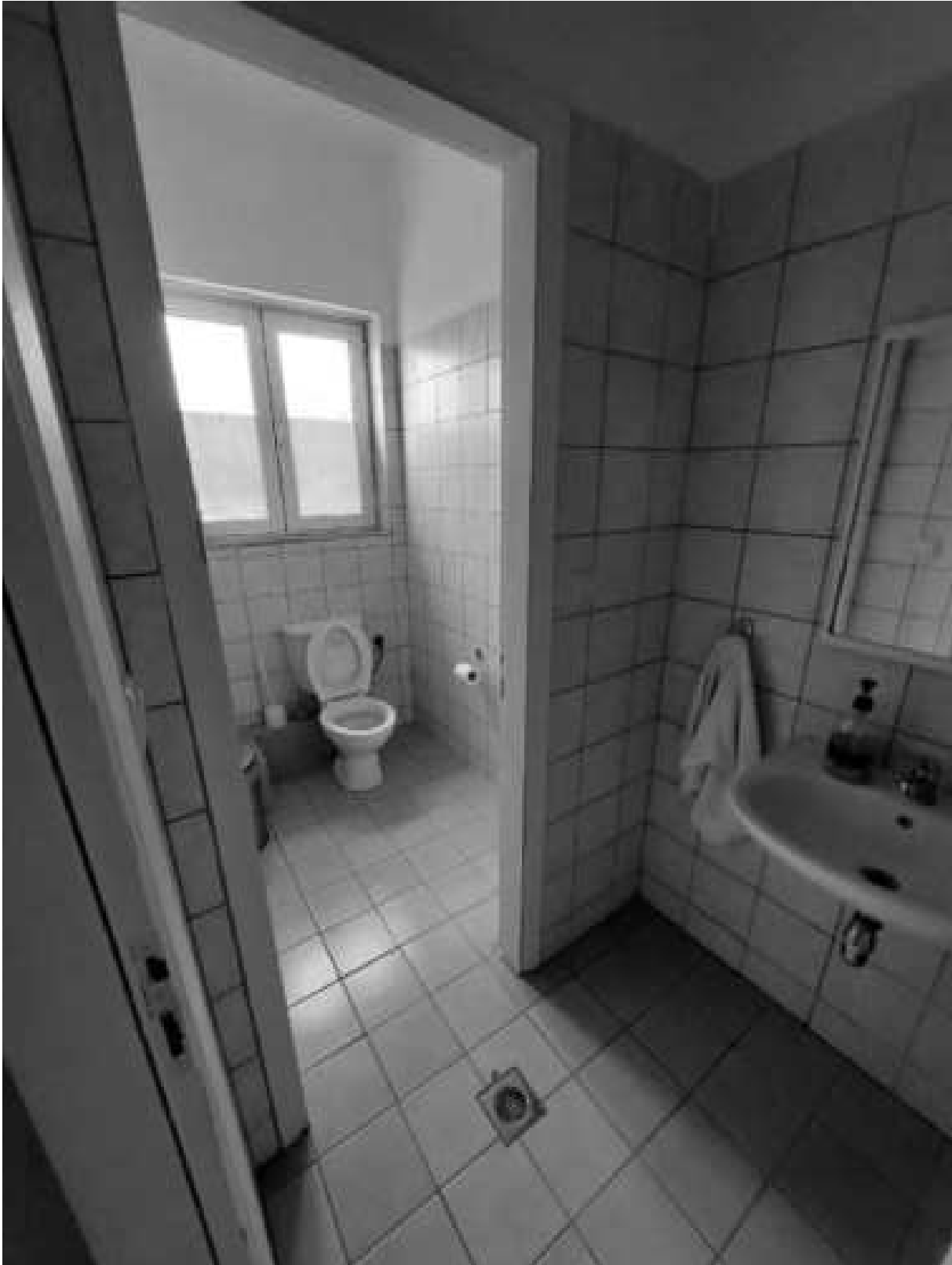
Εικόνα 114: Υφιστάμενος χώρος υγιεινής δασκάλων
