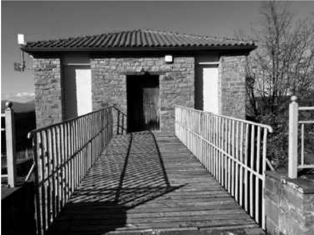
Εικόνα 211: Πόρτα εισόδου από την στάθμη +0,05μ. στην νότια όψη του κτιρίου
