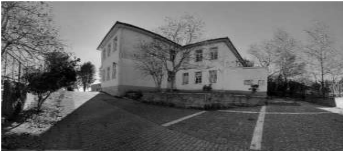
Εικόνα 41: Κεκλιμένο επίπεδο της εισόδου στο Γυμνάσιο Πέτα
