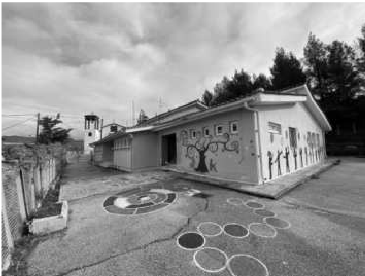
Εικόνα 61: Κύριοι είσοδοι Δημοτικού και Νηπιαγωγείου στην βορειοδυτική πλευρά του κτιρίου
