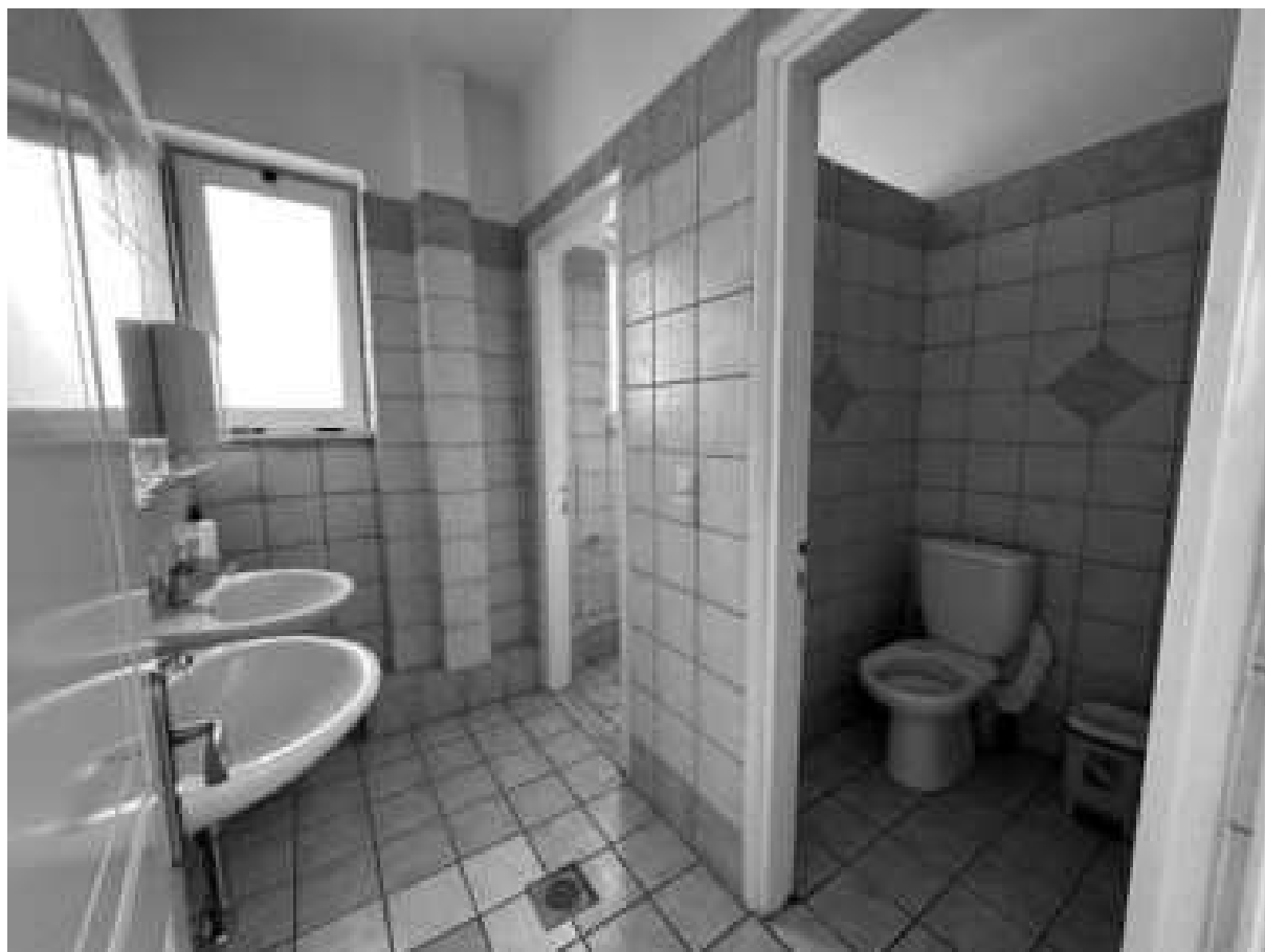
Εικόνα 184: Χώρος υγιεινής του κοινού στον όροφο
