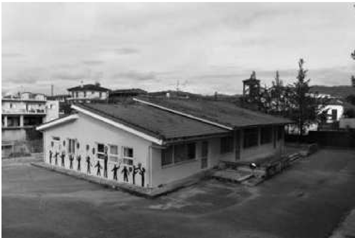
Εικόνα 62: Είσοδοι στην νοτιοανατολική πλευρά του κτιρίου
