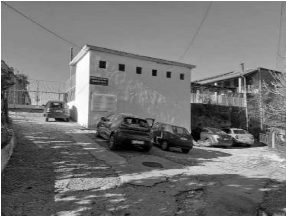
Εικόνα 36: Πρόσβαση της εισόδου του Δημοτικού από τον δρόμο
