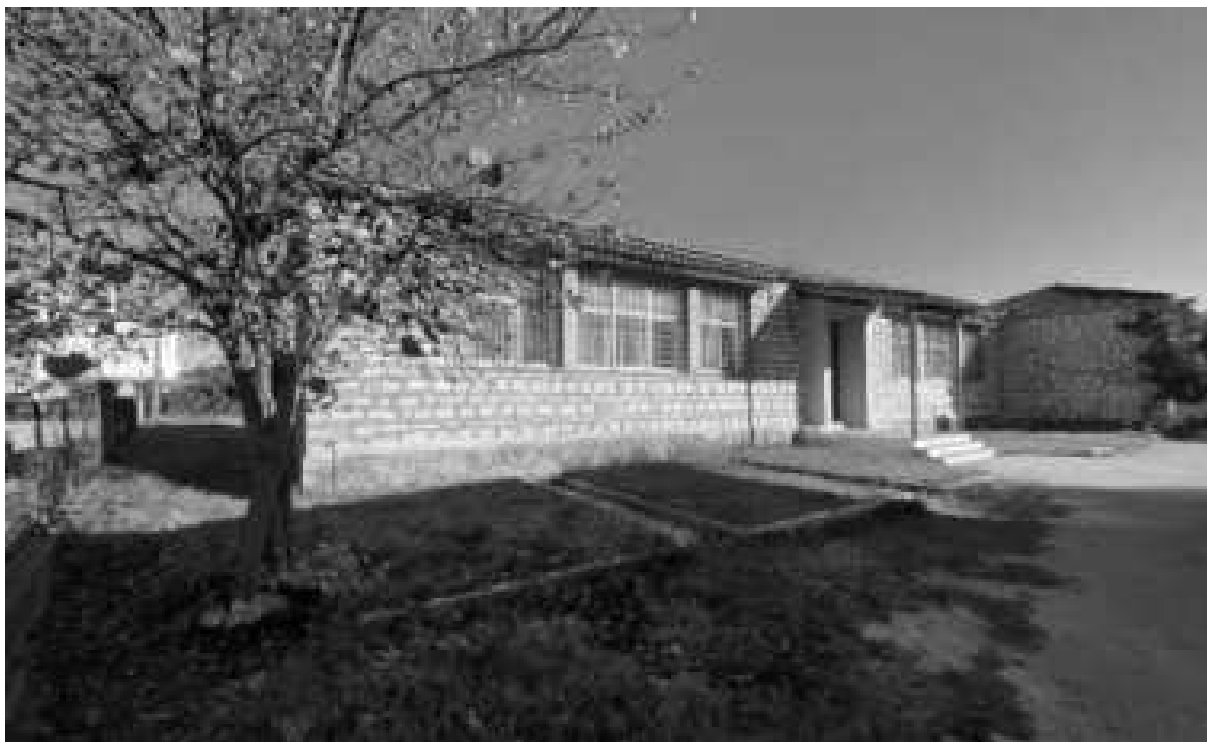
Εικόνα 191: Δημοτικό Σχολείο (Κτίριο 1)
