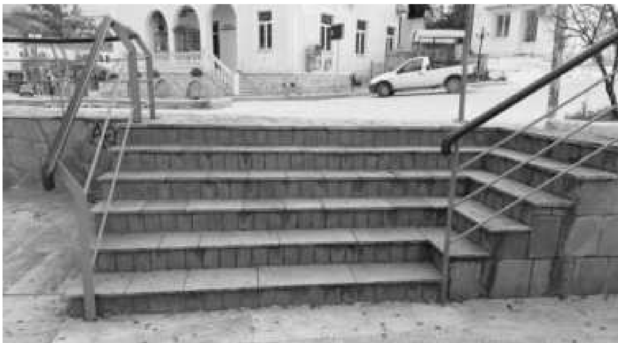
Εικόνα 14: Σκάλα στο ανατολικό τμήμα της πλατείας
