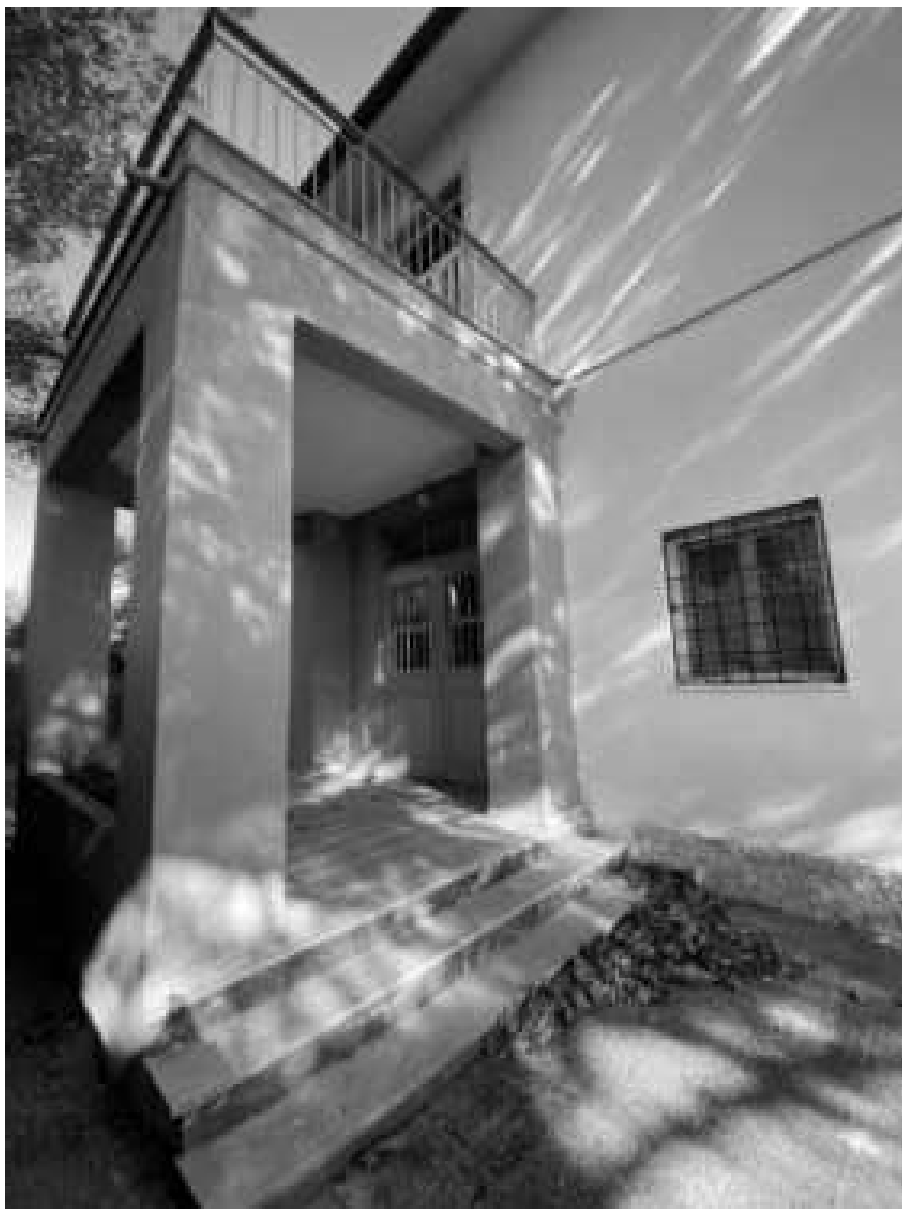
Εικόνα 43: Βοηθητική είσοδος στην Δυτική όψη
