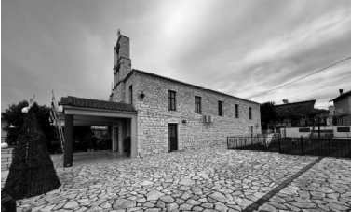
Εικόνα 139: Η νότια όψη της εκκλησίας και η δεύτερη είσοδος της
