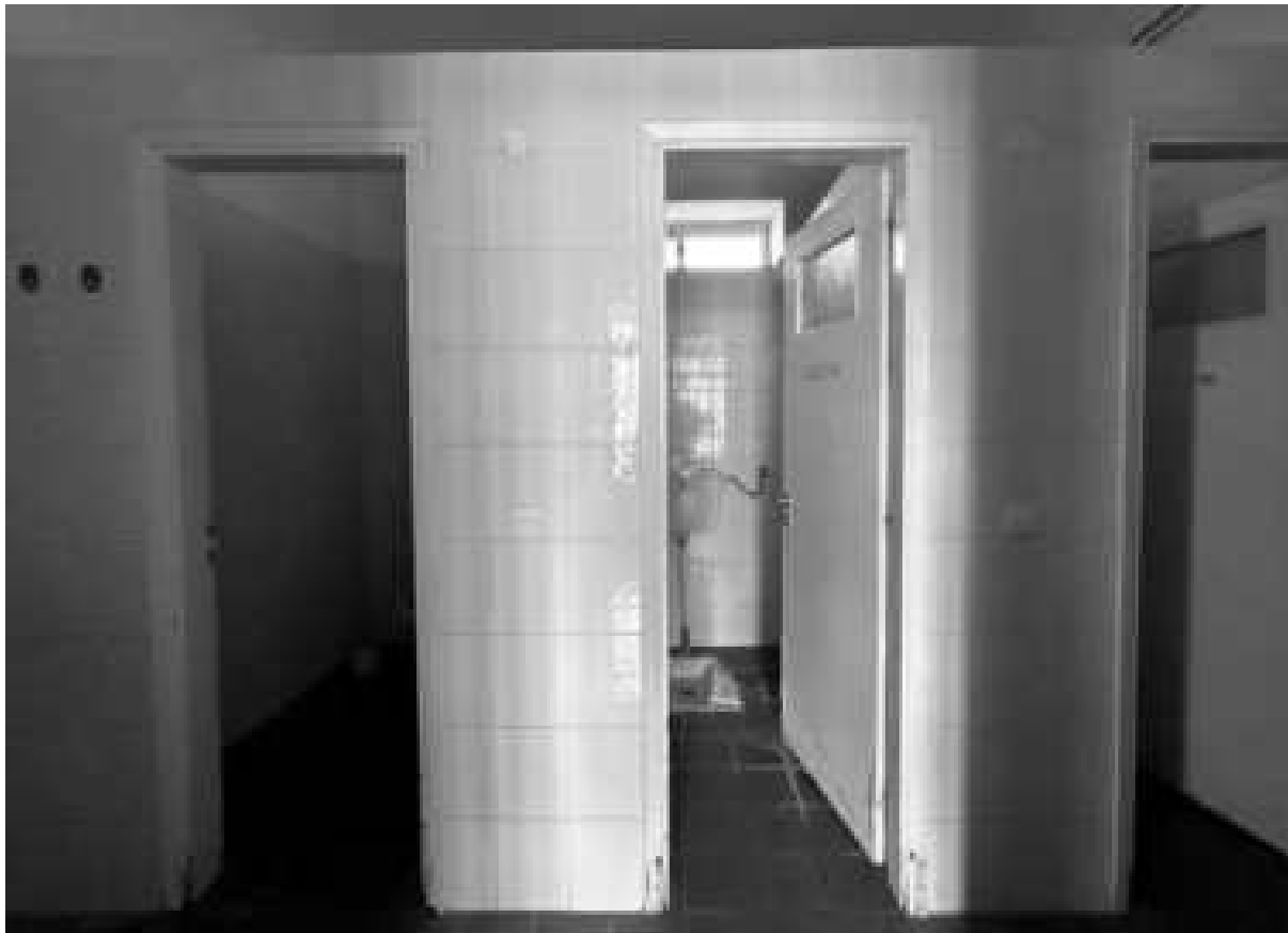
Εικόνα 149: Υφιστάμενοι χώροι υγιεινής
