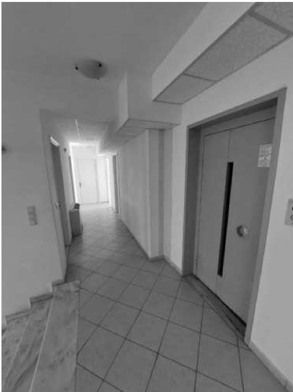
Εικόνα 188: Εσωτερικός διάδρομος με τον ανελκυστήρα στον όροφο του Δημαρχείου
