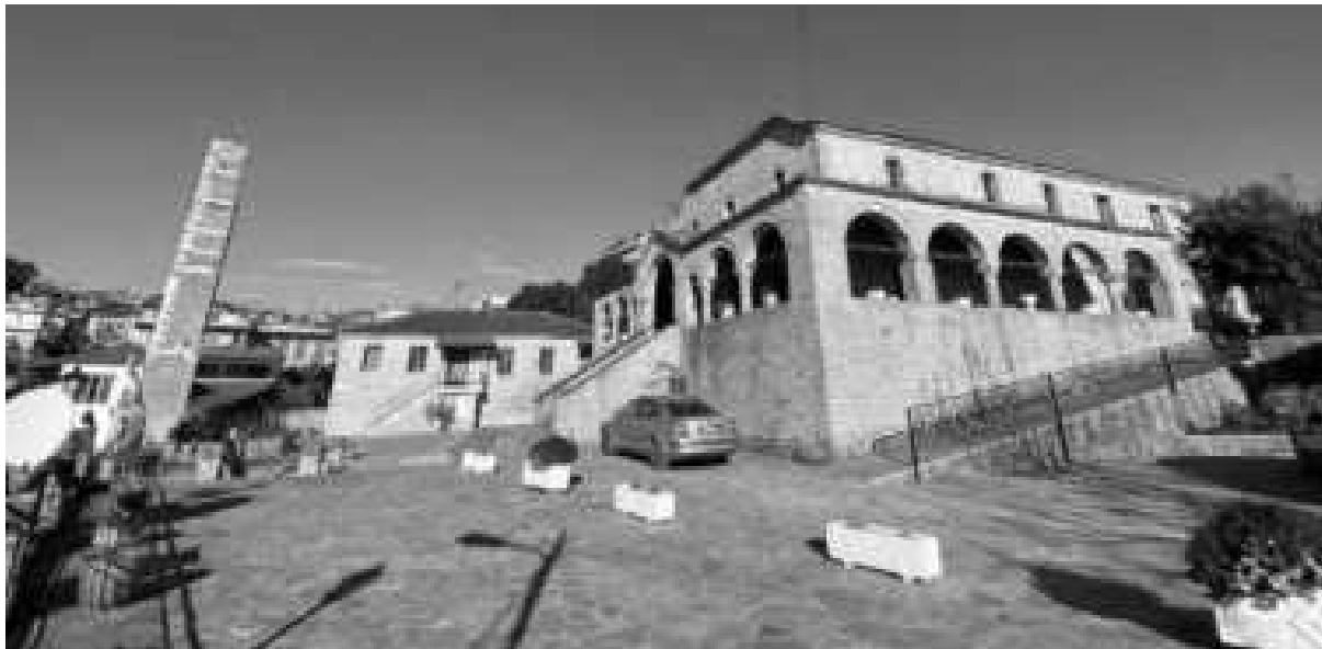
Εικόνα 48: Η υφιστάμενη ράμπα για την πρόσβαση στον ημιυπαίθριο χώρο του ιερού ναού
