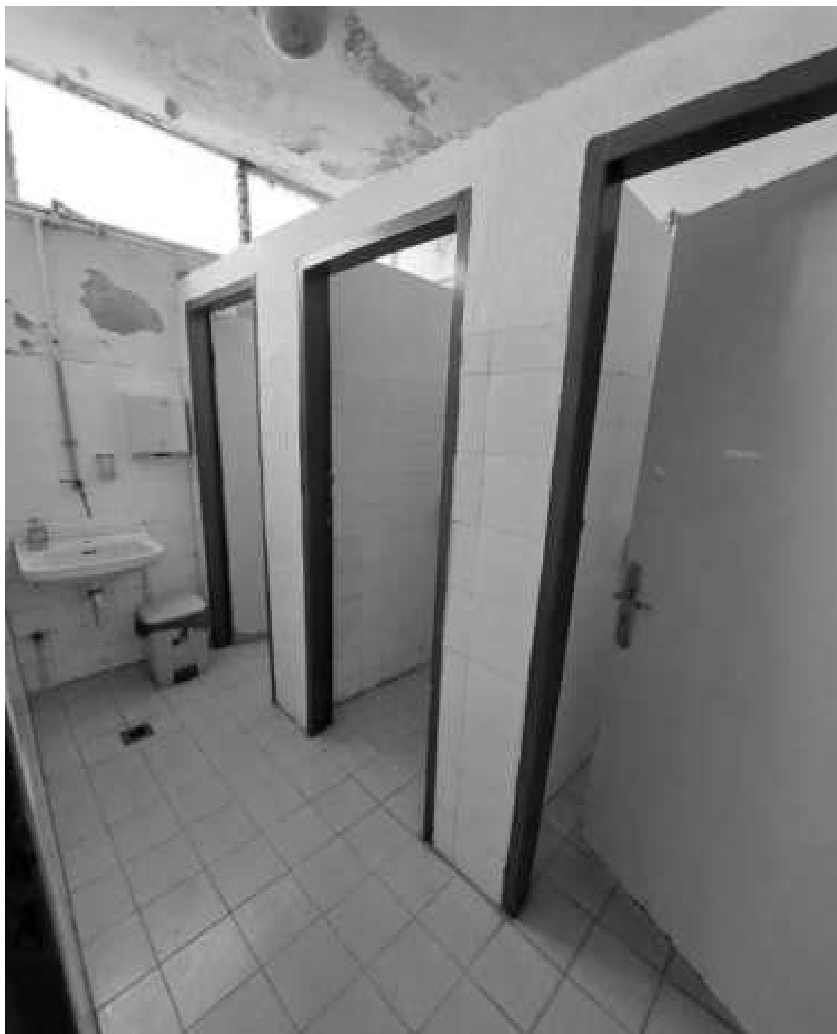
Εικόνα 127: Χώρος υγιεινής μαθητών ισογείου
