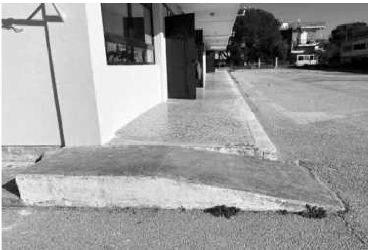
Εικόνα 160: Ράμπα Δημοτικού Σχολείου (Κτίριο 4)
