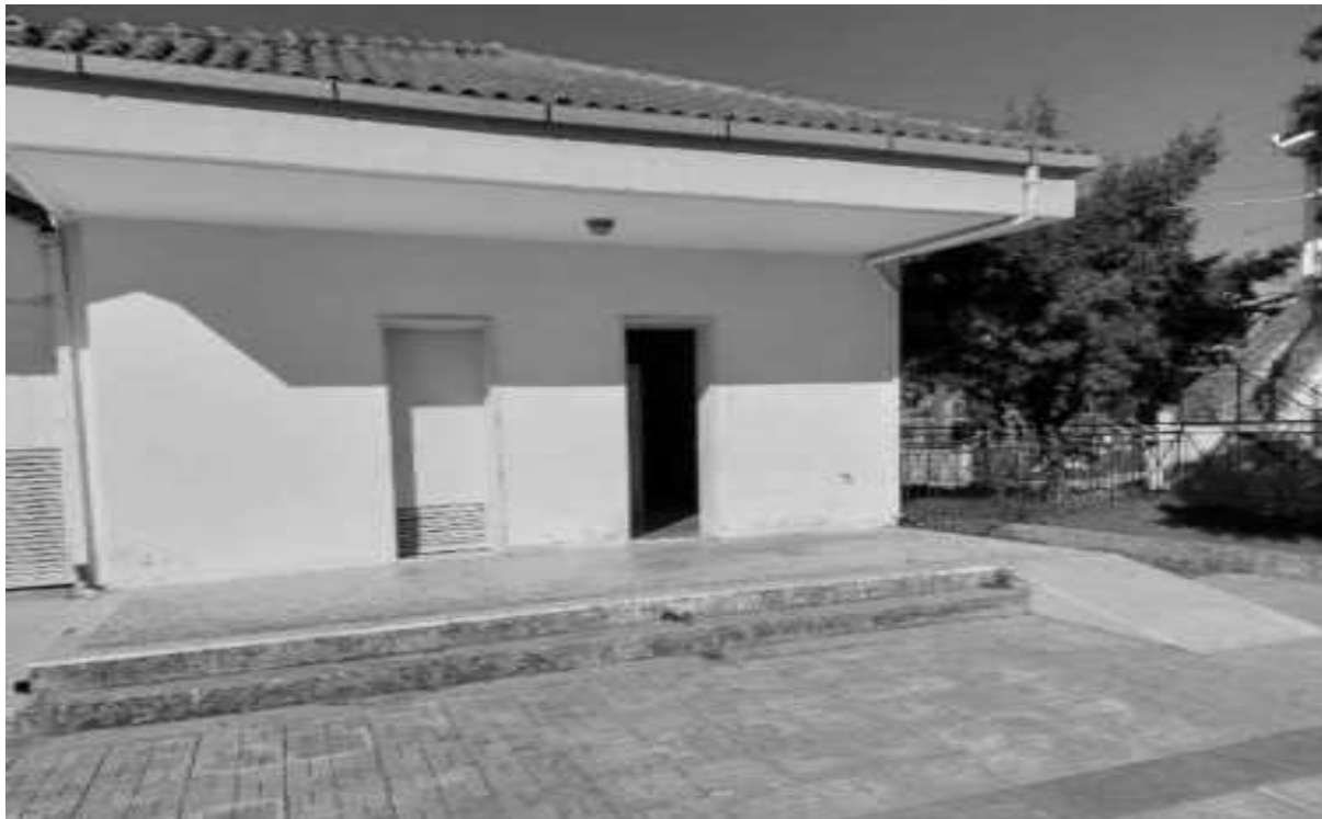
Εικόνα 161: Ράμπα Χώρου Υγιεινής (Κτίριο 3)
