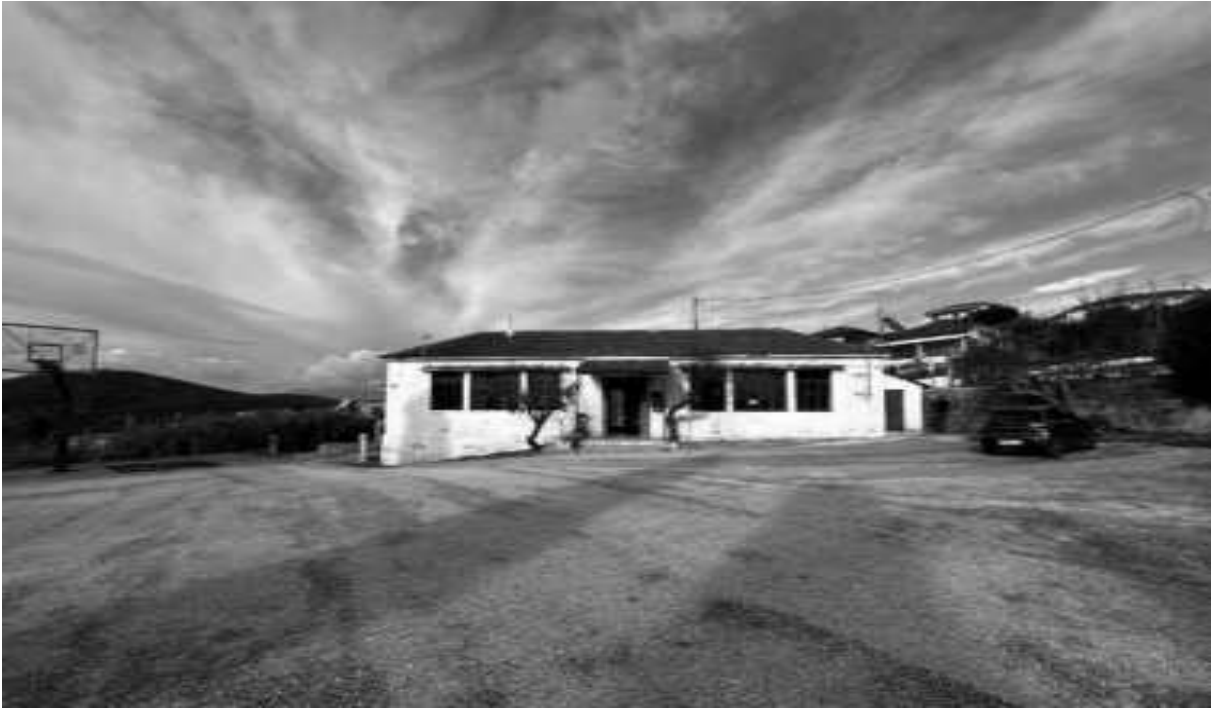
Εικόνα 141: Η νότια όψη του Δημοτικού σχολείου
