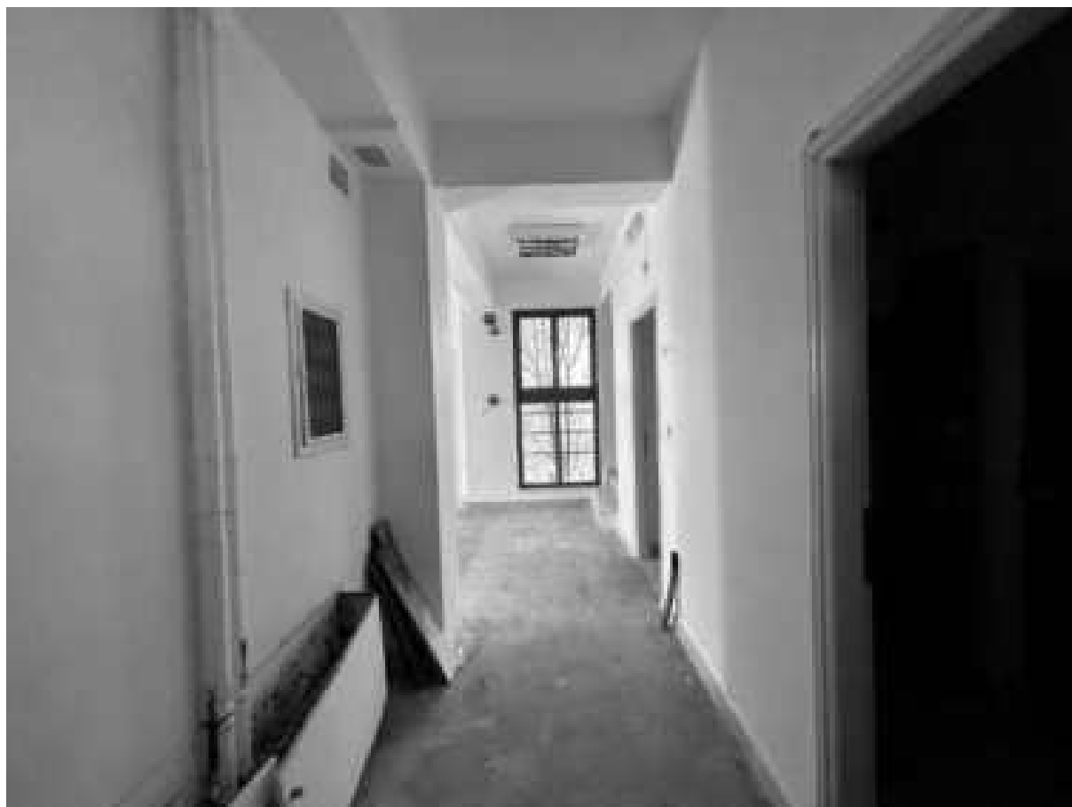
Εικόνα 213: Εσωτερικοί διάδρομοι του ισογείου
