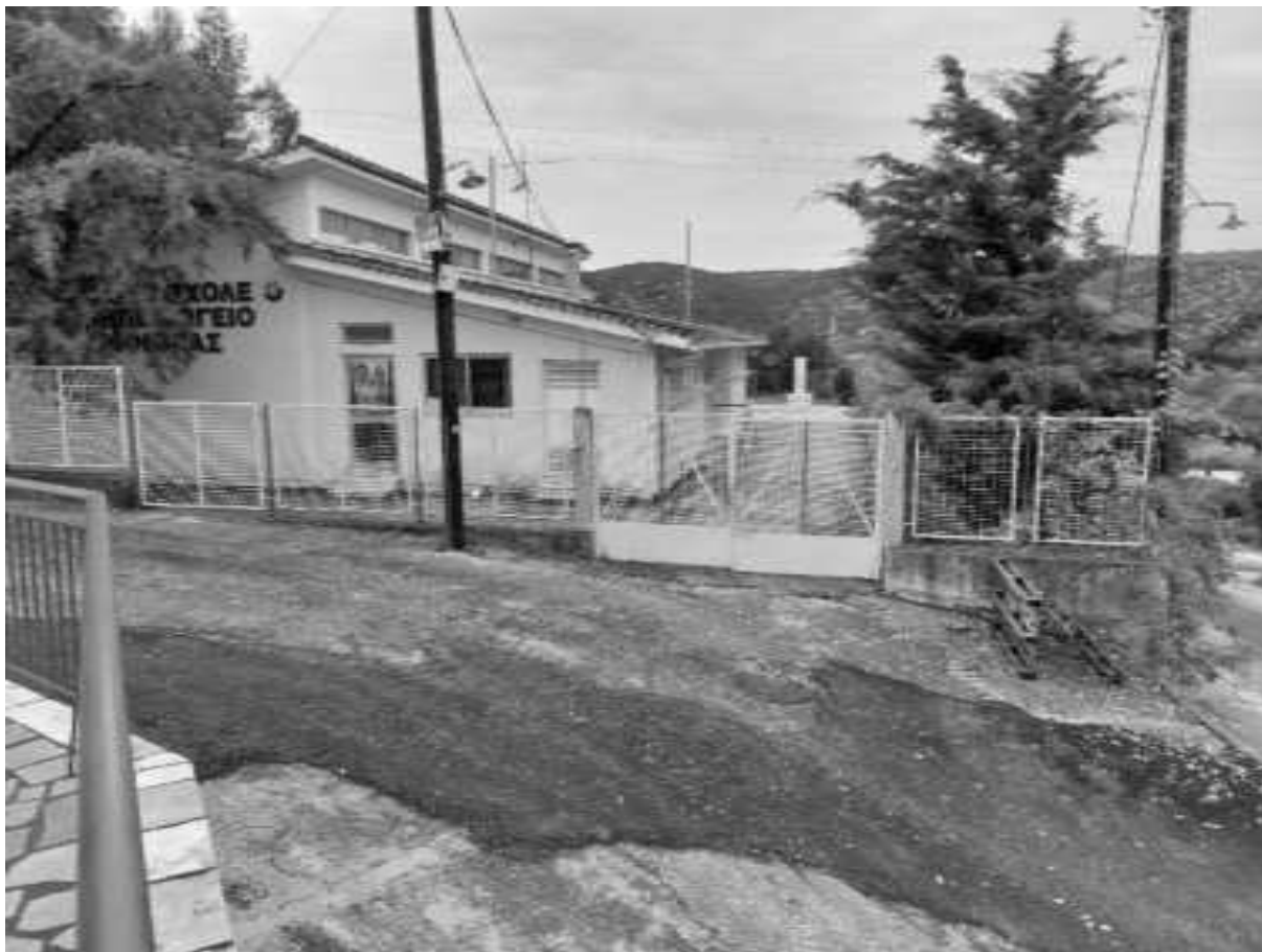
Εικόνα 60: Είσοδος Δημοτικού Σχολείου και Νηπιαγωγείου
