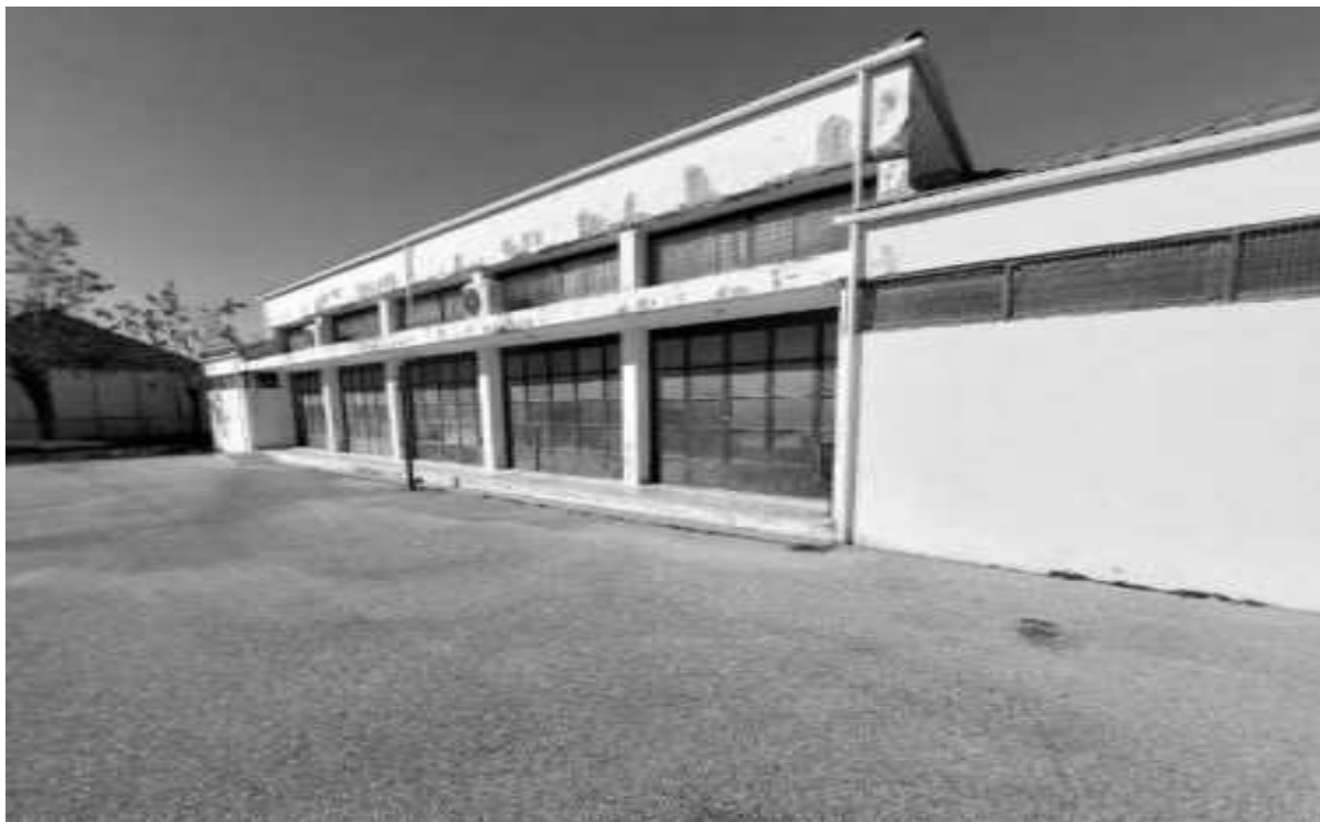
Εικόνα 154: Κλειστό Γυμναστήριο Νεοχωρίου (Κτίριο 7)
