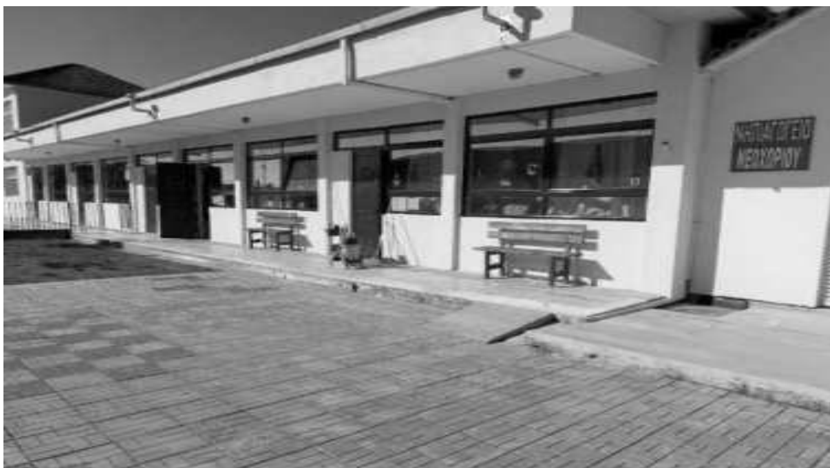
Εικόνα 163: Ράμπα Νηπιαγωγείου (Κτίριο 2)
