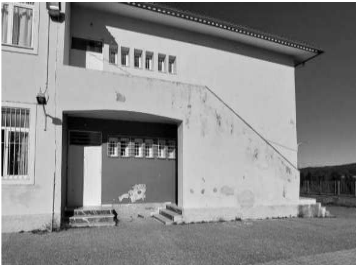
Εικόνα 44: Έξοδος κινδύνου στην νότια όψη
