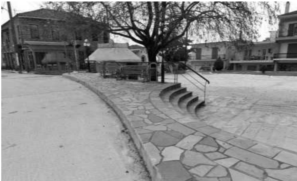
Εικόνα 18: Υφιστάμενη κατάσταση των πεζοδρομίων στο ανατολικό τμήμα της πλατείας
