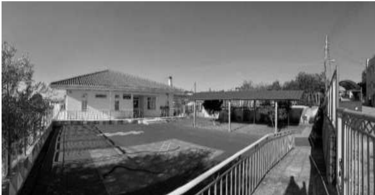
Εικόνα 31: Ράμπες στον αύλειο χώρο του Νηπιαγωγείου
