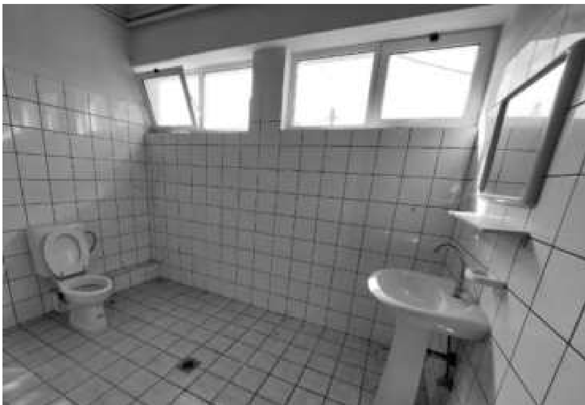
Εικόνα 136: Χώρος υγιεινής ΑΜΕΑ καθηγητών
