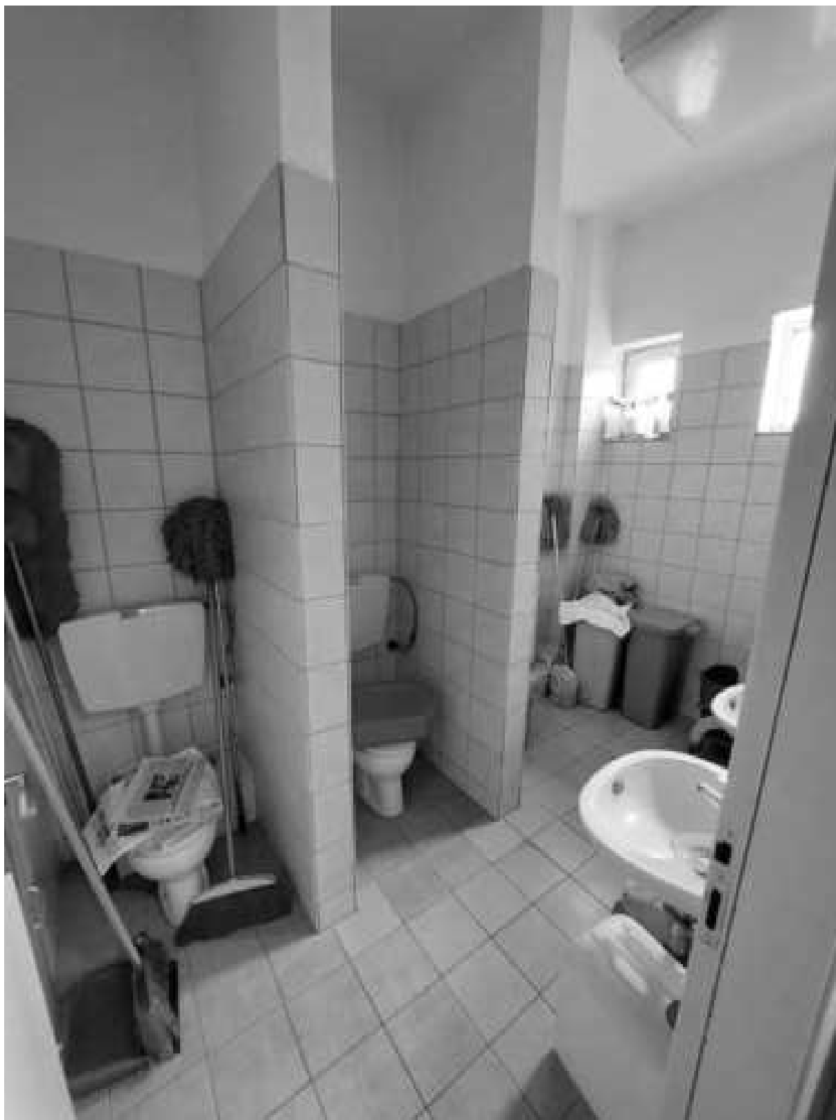
Εικόνα 113: Υφιστάμενος χώρος υγιεινής νηπίων και χώρος αποθήκης
