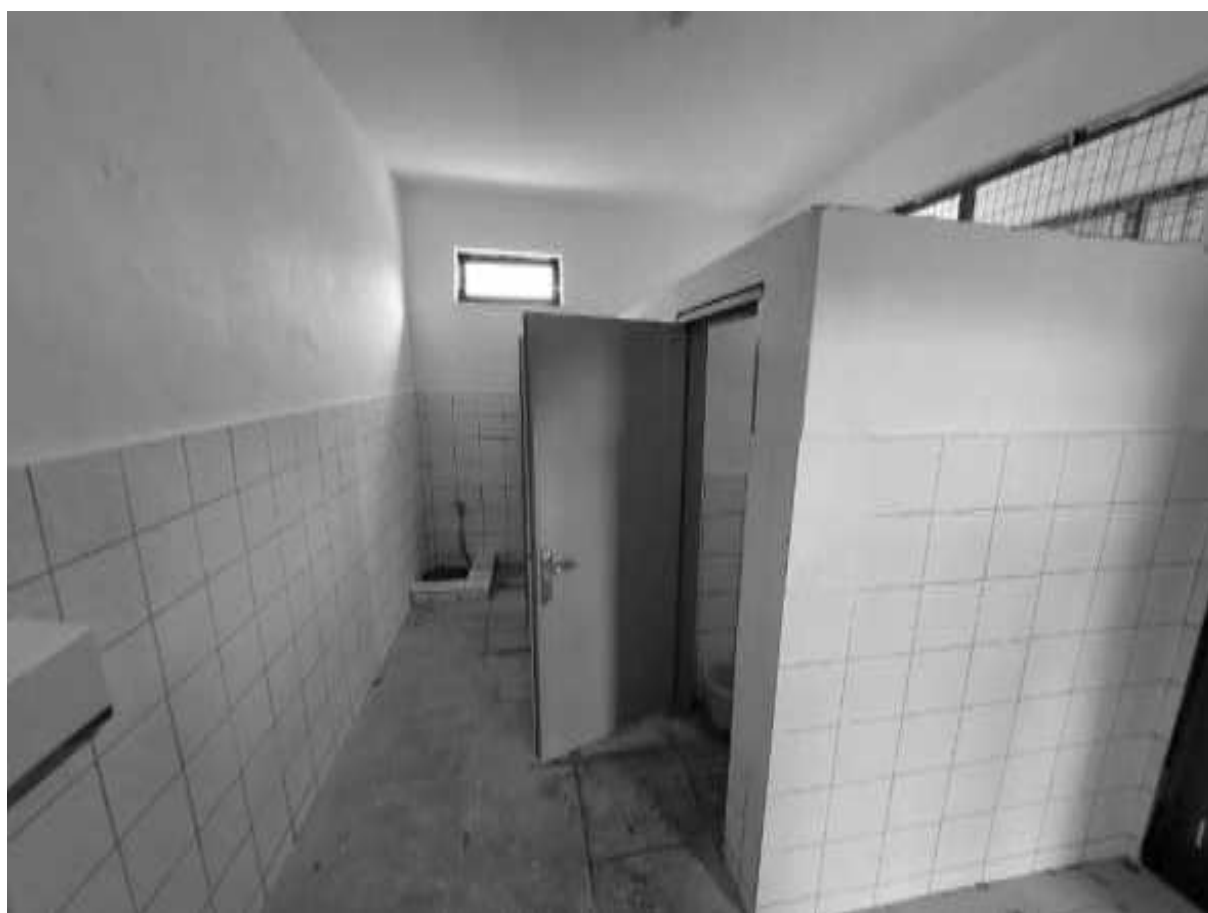
Εικόνα 108: Υφιστάμενοι χώροι υγιεινής
