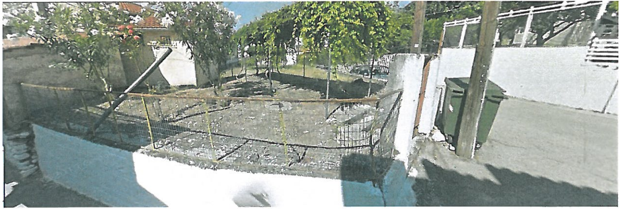
Εικόνα 9 : Λεπτομέρεια της υφιστάμενης κατάστασης της εισόδου από το βορειοανατολικό άκρο της περιοχής. Ο δρόμος σε σχέση με την πρόσβαση στην περιοχή μελέτης στο σημείο αυτό, παρουσιάζουν υψομετρική διαφορά, η οποία γεφυρώνεται με σκαλοπάτια.
