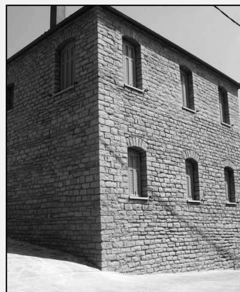
Ανακατασκευή κατοικίας στο Μοστρέικο.
