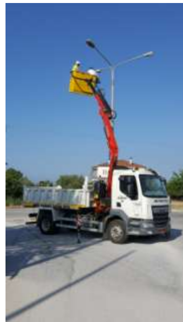
Εργασίες στο δίκτυο ηλεκτροφωτισμού
